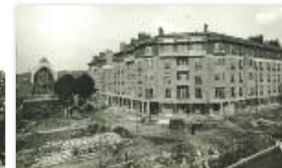
Notre-Dame de la Paix en construction.
