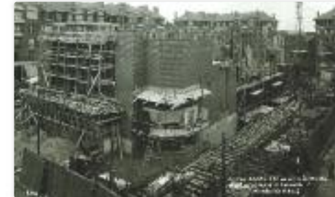
Le centre social Albert Thomas en construction.
